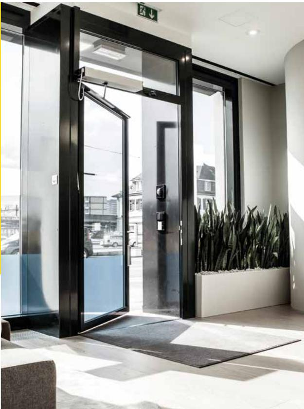
Le mécanisme d'entraînement électromécanique est silencieux et convient tant aux portes intérieures légères qu'aux portes extérieures lourdes exposées à des charges de vent élevées et devant résister à une forte fréquence de passages. Le mécanisme d'entraînement est puissant, résistant au vandalisme et peut donc être utilisé à n'importe quel endroit.
